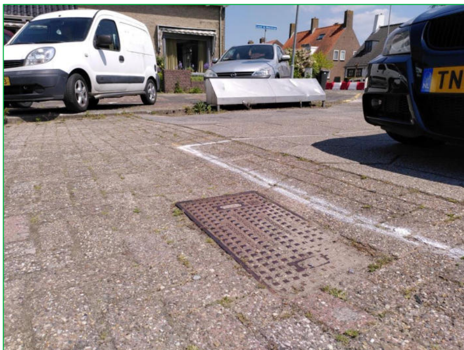
Foto 4 Voormalige vulpunten bekisting met olieafscheider op voorgrond
