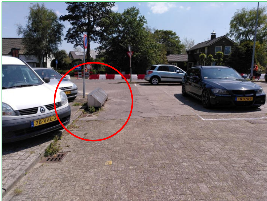
Foto 3 Voormalige vulpunten bekisting
