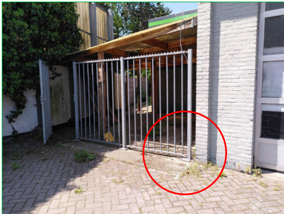
Foto 8 Vulpunt en tankontluchting Voormalige ondergrondse tank voor afgewerkte olie (boringen 801 t/m 805)
