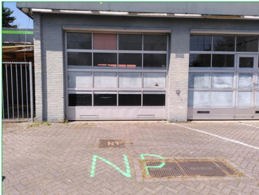
Foto 7 Voormalige wasplaats met slibvanger en olieafscheider op voorgrond (boring 901)
