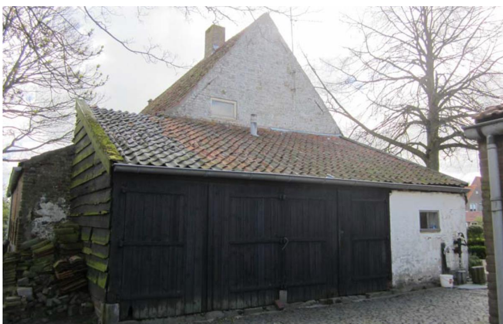
Afbeelding 11: Achtergevel van de boerderij en de te slopen aanbouw
