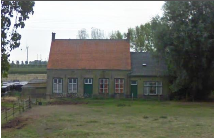
Figuur 2-1: Foto woning voor de brand
