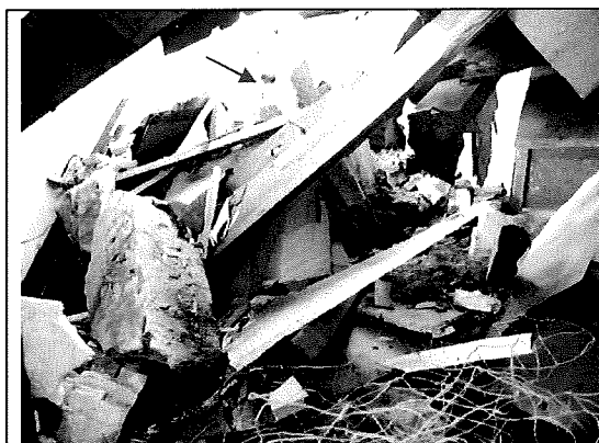
Stukken beplating in ingestorte opstal (M01/M02)
