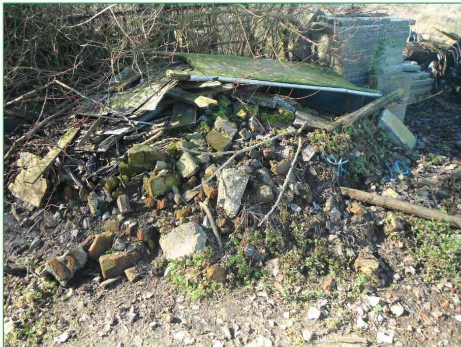
Foto 3 Puin op maaiveld
