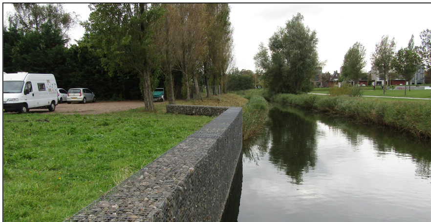
Figuur: een deel van de oever is beschoeid. In dit deel van de oever zijn geen ecologische risico's van toepassing.
