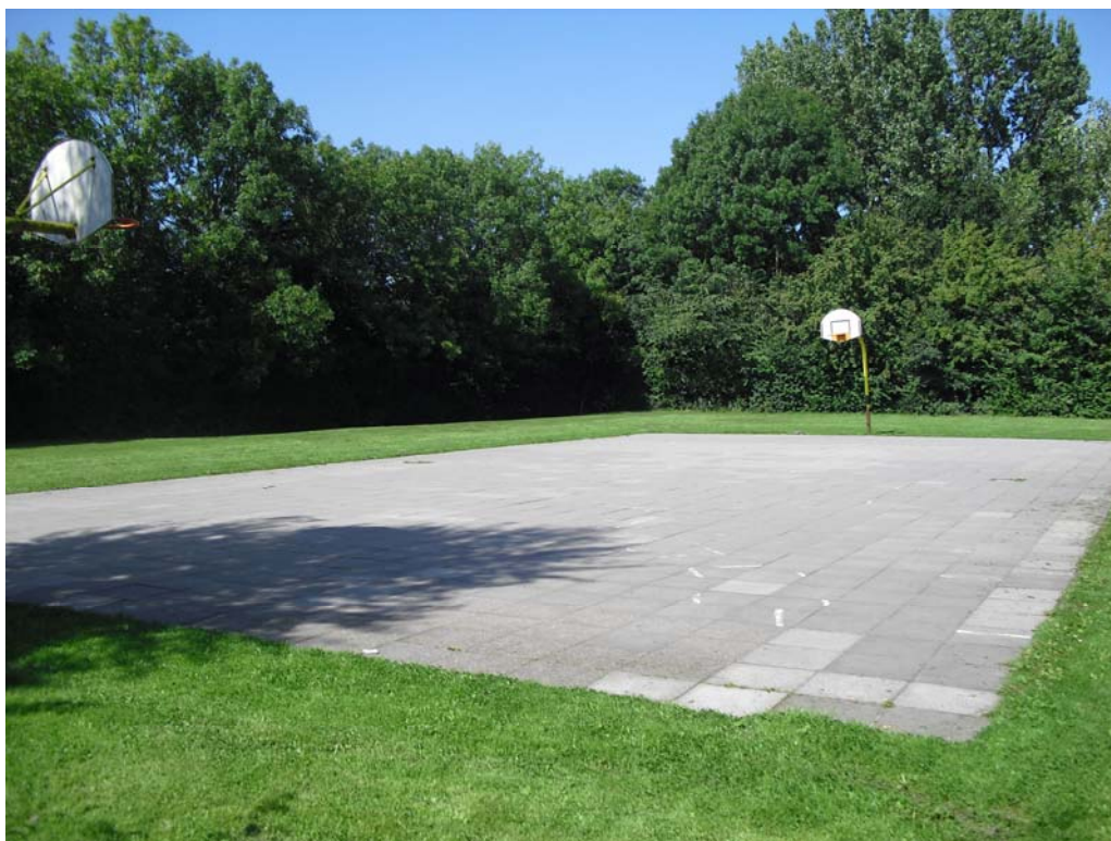
Foto 2: foto van voormalige locatie kassen, risicolocatie kassen
