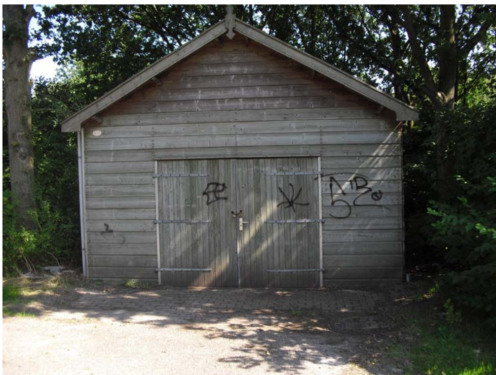
Foto 3: foto van risicolocatie garagebox
