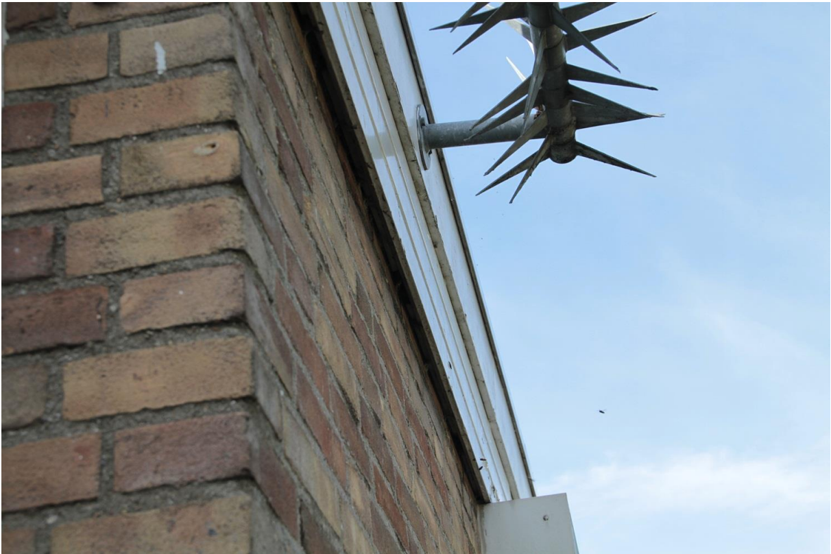
Foto 5. Bebouwing met daklijsten.
