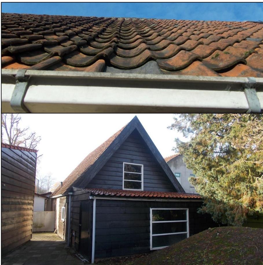
Foto 6 en 7: Kieren tussen de dakpannen en ruimte onder de dakgoot.
