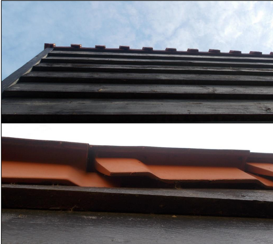
Foto 4 en 5: Kieren onder de dakpannen van perceel 2818.
