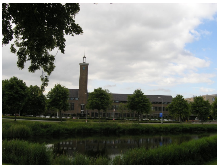
Afbeelding 3.20: PZEM gebouw met dienstwoning
