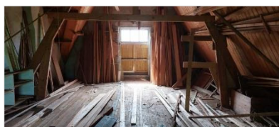
Figuur 2.6 Zolder kantoorgebouw (deelgebied B).
