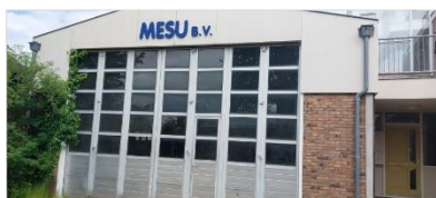
Figuur 2.3 Voorzijde van de loods in deelgebied A.
