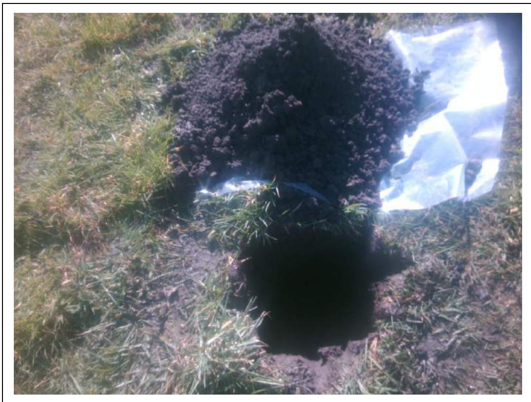
Foto 6: asbestinspectiegat B06
