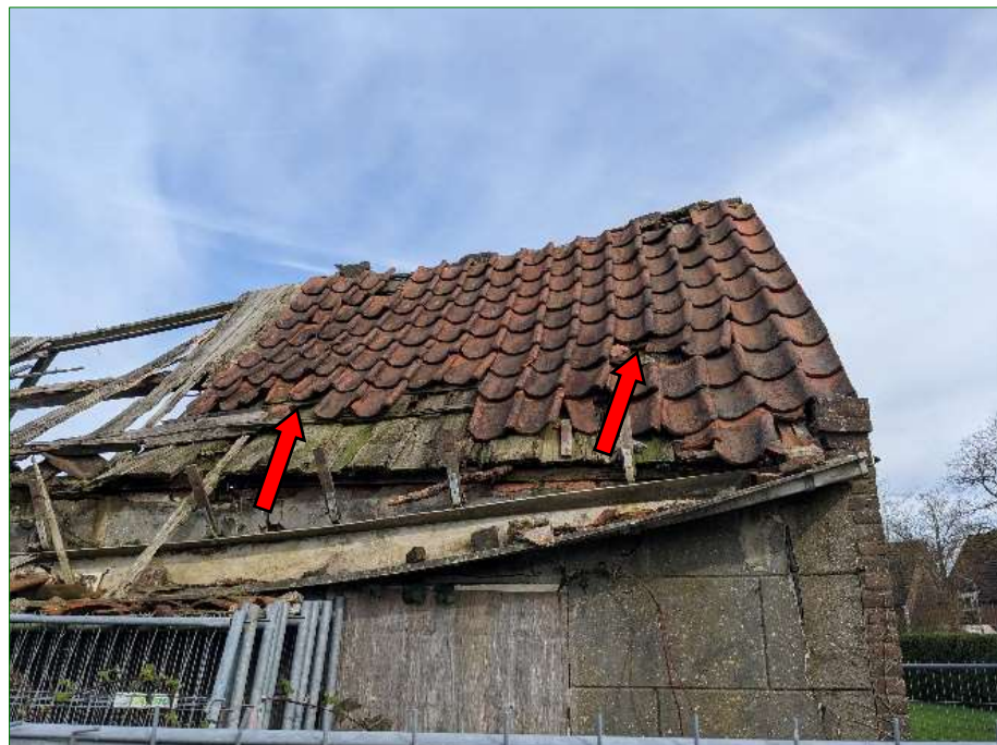
De openingen (rode pijlen) van de bebouwing geven mogelijk toegang tot voor (dwerg)vleermuizen geschikte achterliggende ruimtes.
