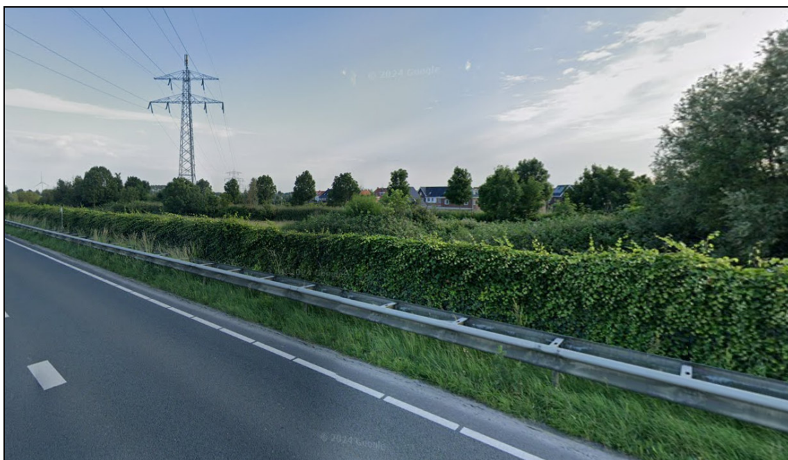
Figuur 2: Geluidsschermb langs de zuidwestzijde van de N57 ter plaatse van Mortiere, Middelburg
