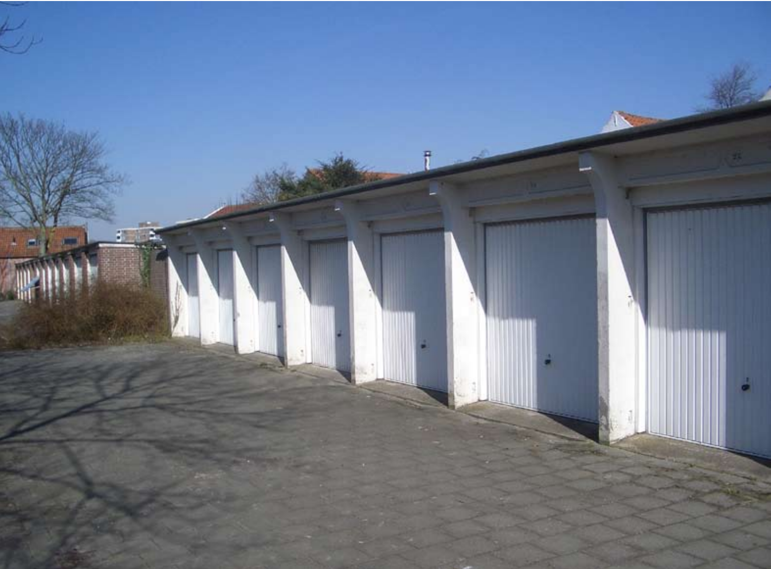
garages aan de Essenlaan
