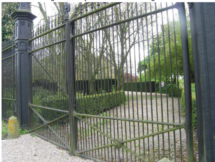
Hekwerk aan de Nieuwlandseweg
