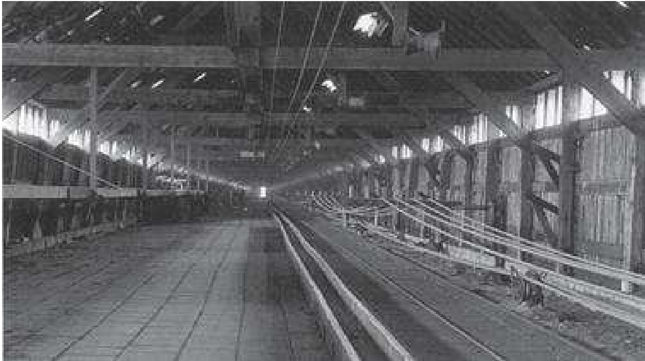
Fig. 6: De touwbaan van touwfabriek G. van der Lee bv., met houten wanden en eenvoudige dakstructuur kan een idee van de mogelijke constructie van het VOC gebouw geven ( home.hccnet.nl )
