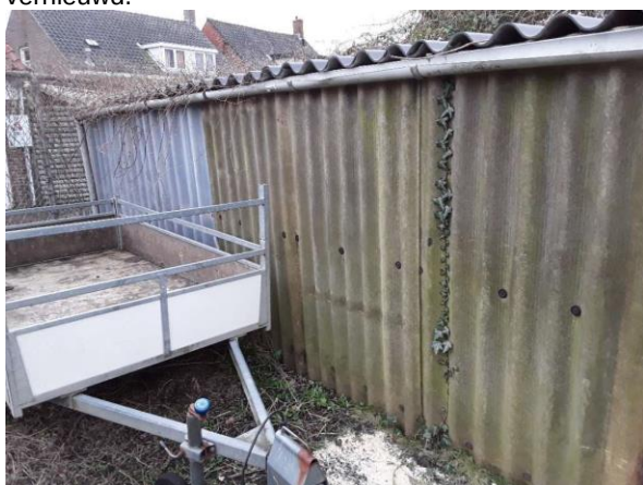
Verder bestaat de berging voor op het perceel uit lichtplaten.
