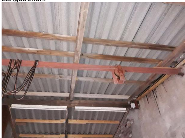
Het dak van de aangrenzende berging is een aantal jaren vernieuwd.
