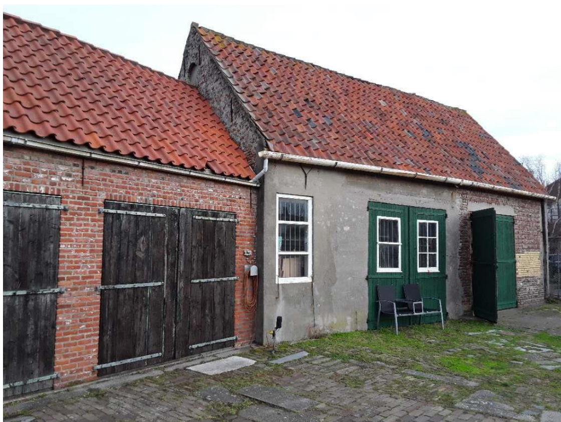
De opstallen aan de Vogelstraat 18/20 te Middelburg
