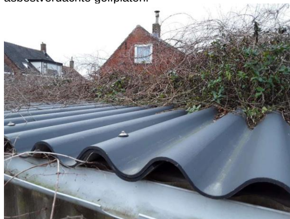
Het dak van de berging voor op het perceel is tevens vernieuwd.
