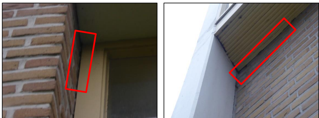
Voorbeelden van openingen die geschikt zijn voor vleermuizen.
