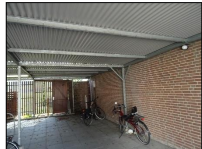
Figuur 5. Binnen in de fietsenstalling.
