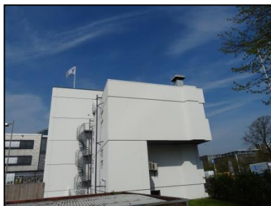
Figuur 7. Deel hoofdbebouwing dat gesloopt wordt.
