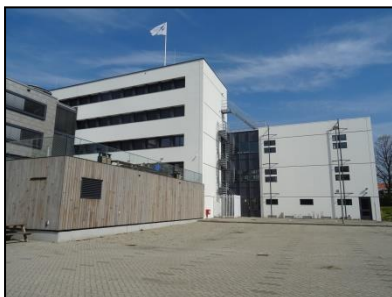
Figuur 6. Hoofdbebouwing op de onderzoekslocatie.
