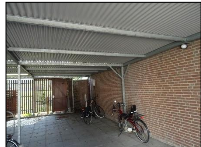
Figuur 5. Binnen in de fietsenstalling.
