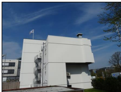
Figuur 7. Deel hoofdbebouwing dat gesloopt wordt.
