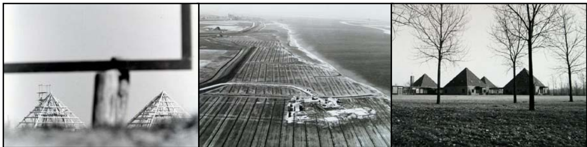
Figuur 21: Enkele foto's van de bouw van Het Zilveren Schor. De eerste 'steen' werd gelegd in 1964 [links], het instituut kreeg vorm in 1965 [midden] om uiteindelijk de karakteristieke piramide gebouwen te verkrijgen zoals zichtbaar op een foto uit het begin van de jaren '80 [rechts] (Bron: De geschiedenis van Zeeland, 2014 )
