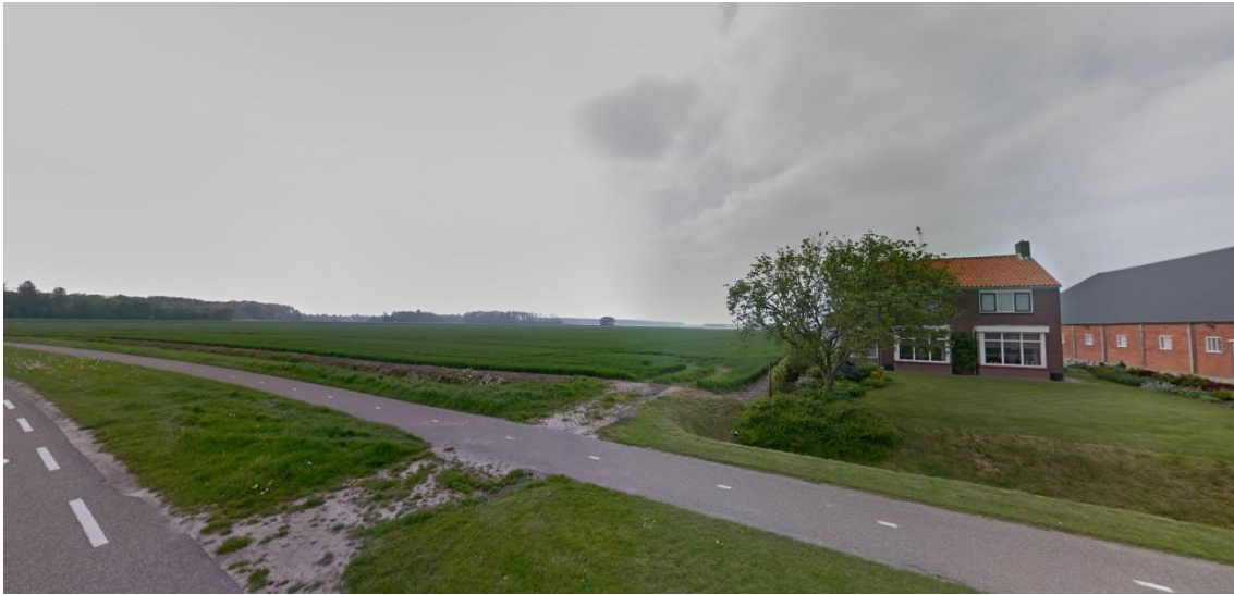
Afbeelding 3.12.: Impressie van het agrarisch gebied langs de Muidenweg, met rechts de bedrijfsbebouwing ter hoogte van huisnummer 11 (bron: Google Streetview).
