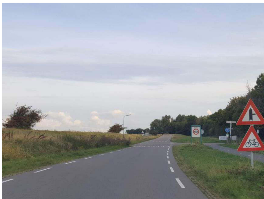
Foto 3 aansluiting fietsroute op de Oranjepolderseweg – Muidenweg.
