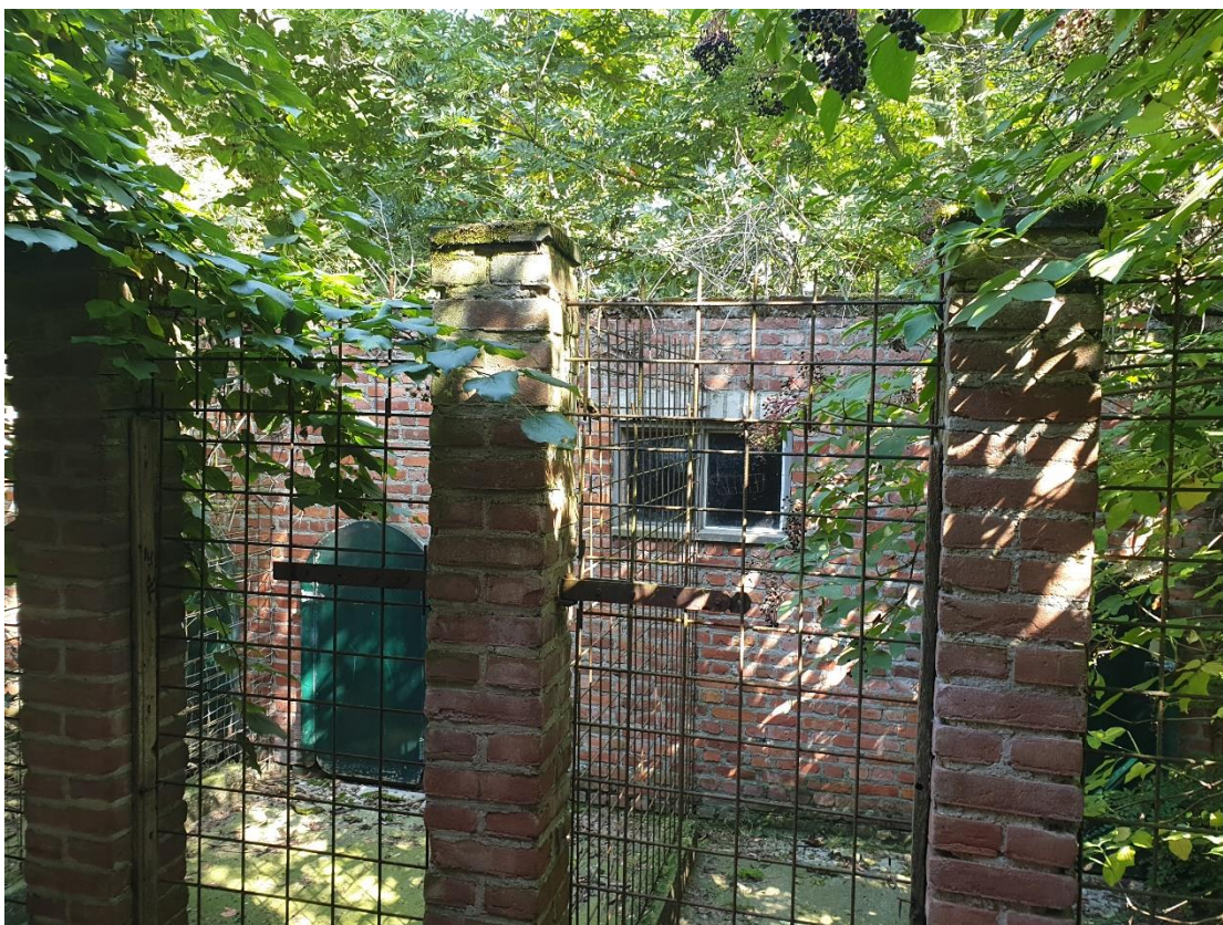
Foto 10. Pand 5 aanzicht zuidzijde
