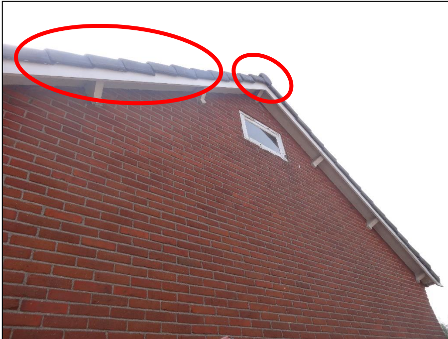
Figuur 6. Geschikte invliegopeningen voor gebouwbewonende vleermuizen die toegang verschaffen tot potentieel geschikte verblijfsruimte(s).
