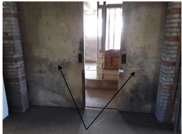
Beplating deur en wand
