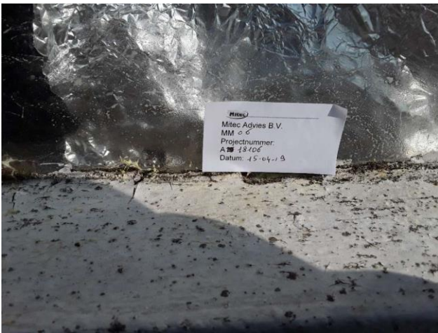
Glaskit in betonkozijn
