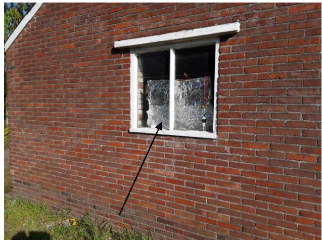
Glaskit in betonkozijn
