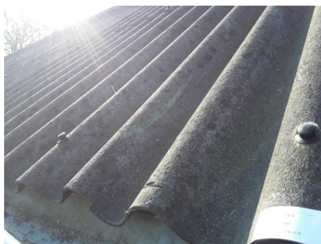
Dak kleine schuur
