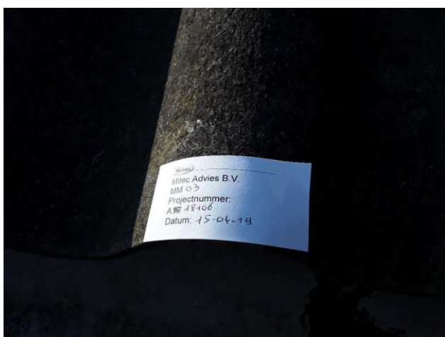
Dak kleine schuur
