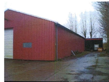
schuur en loods noordwestzijde
