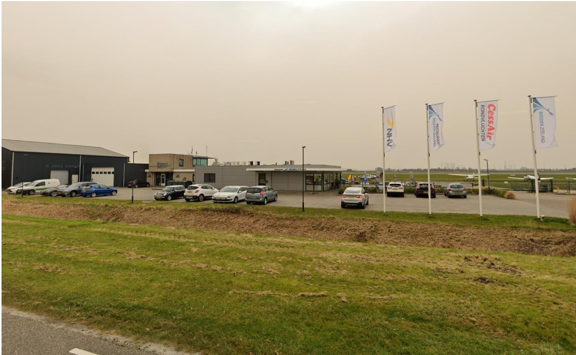
Afbeelding 2.6.: Bestaand luchtvaartgebouw Vliegveld Midden-Zeeland met opbouw (bron: Google Maps)
