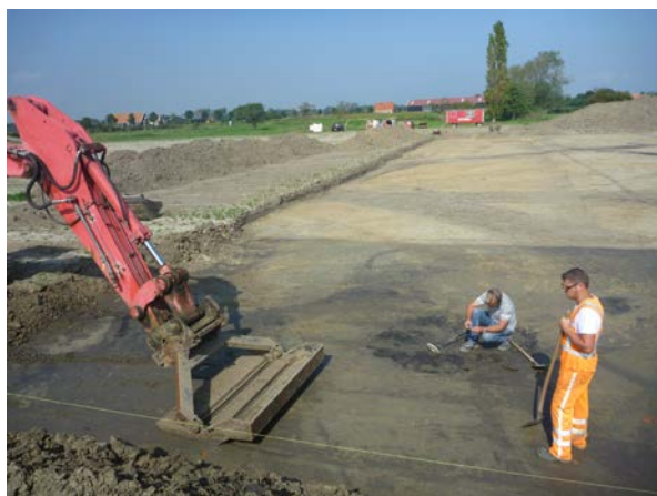
Fig. 4 - Aanleggen vlak met kraan en schaafebak
