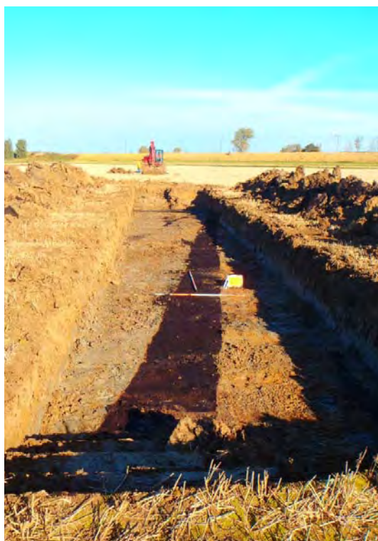
Afb. 10. Moerteringsputten en Veendammen in werkput 10.
