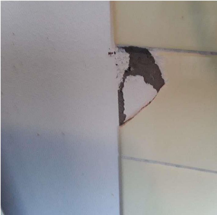
Achter het tegelwerk zijn geen asbestverdachte lijmlagen aangetroffen.
