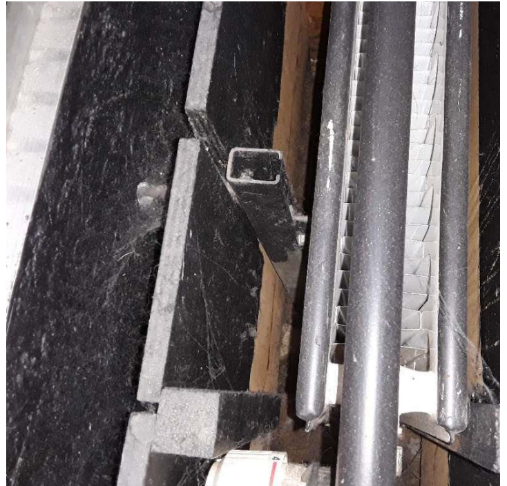
In de convectorputten zijn geen asbestverdachte materialen aangetroffen.
