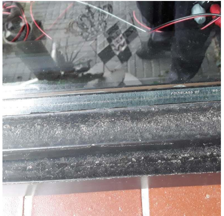
De raamkozijnen zijn in 1996 vervangen.
