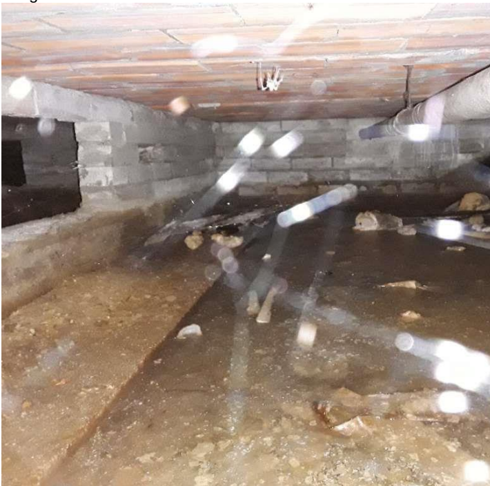
In de kruipruimte zijn geen asbestverdachte materialen aangetroffen.
