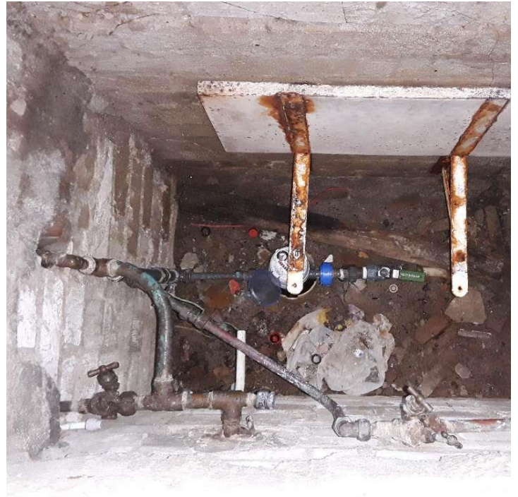
In de watermeterput zijn geen asbestverdachte materialen aangetroffen.
