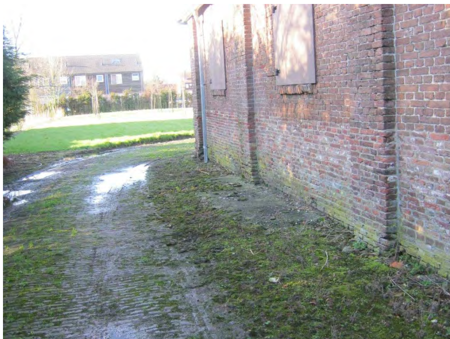
IMG_0512, zuidzijde pand met klinkerverharding op het buitenterrein
