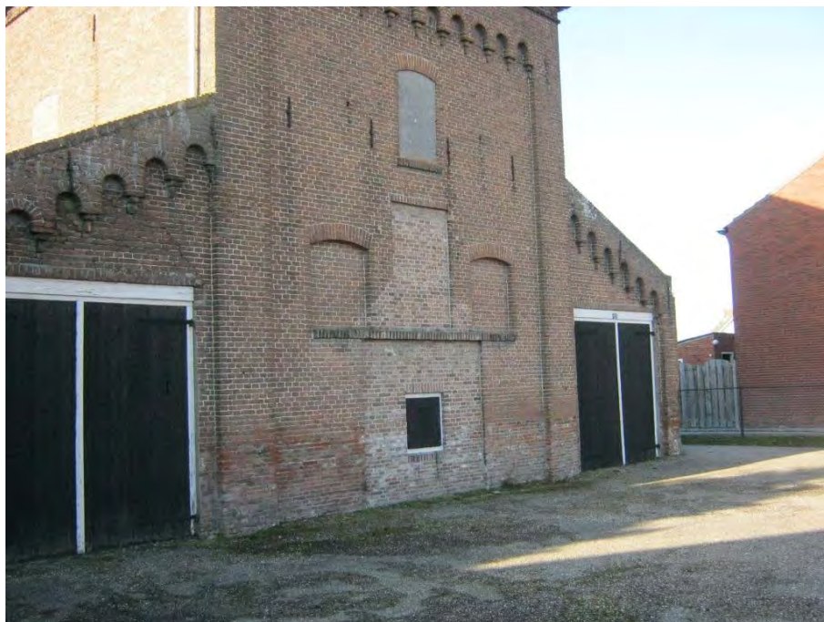
IMG_0520, oostzijde pand met asfaltverharding op het buitenterrein (aan de Ooststraat)
