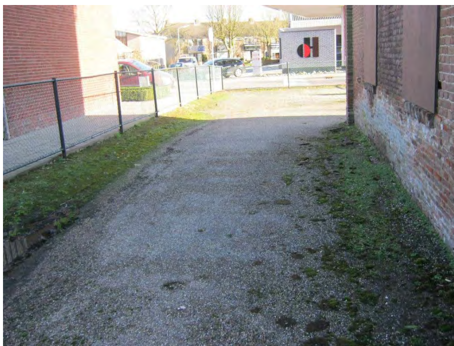
IMG_0515, noordzijde pand met asfalt/puinverharding op het buitenterrein
