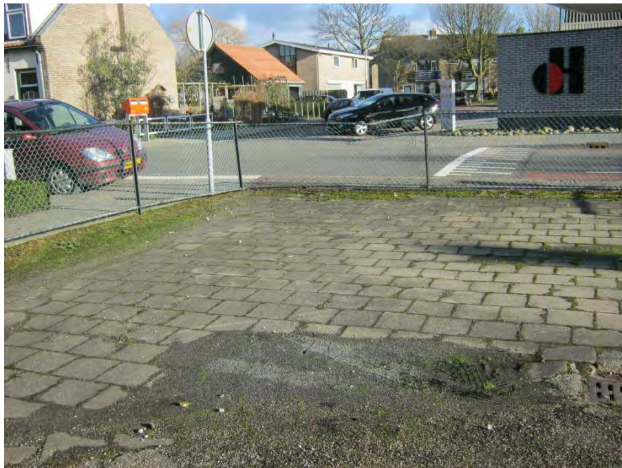
IMG_0516, tegelverharding op het buitenterrein aan de noordzijde van de onderzoekslocatie
