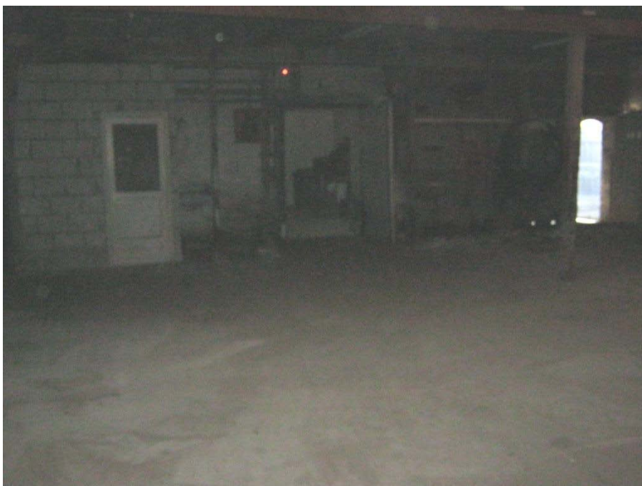
IMG_0508, betonverharding in het pand met op de achtergrond een koelcel
