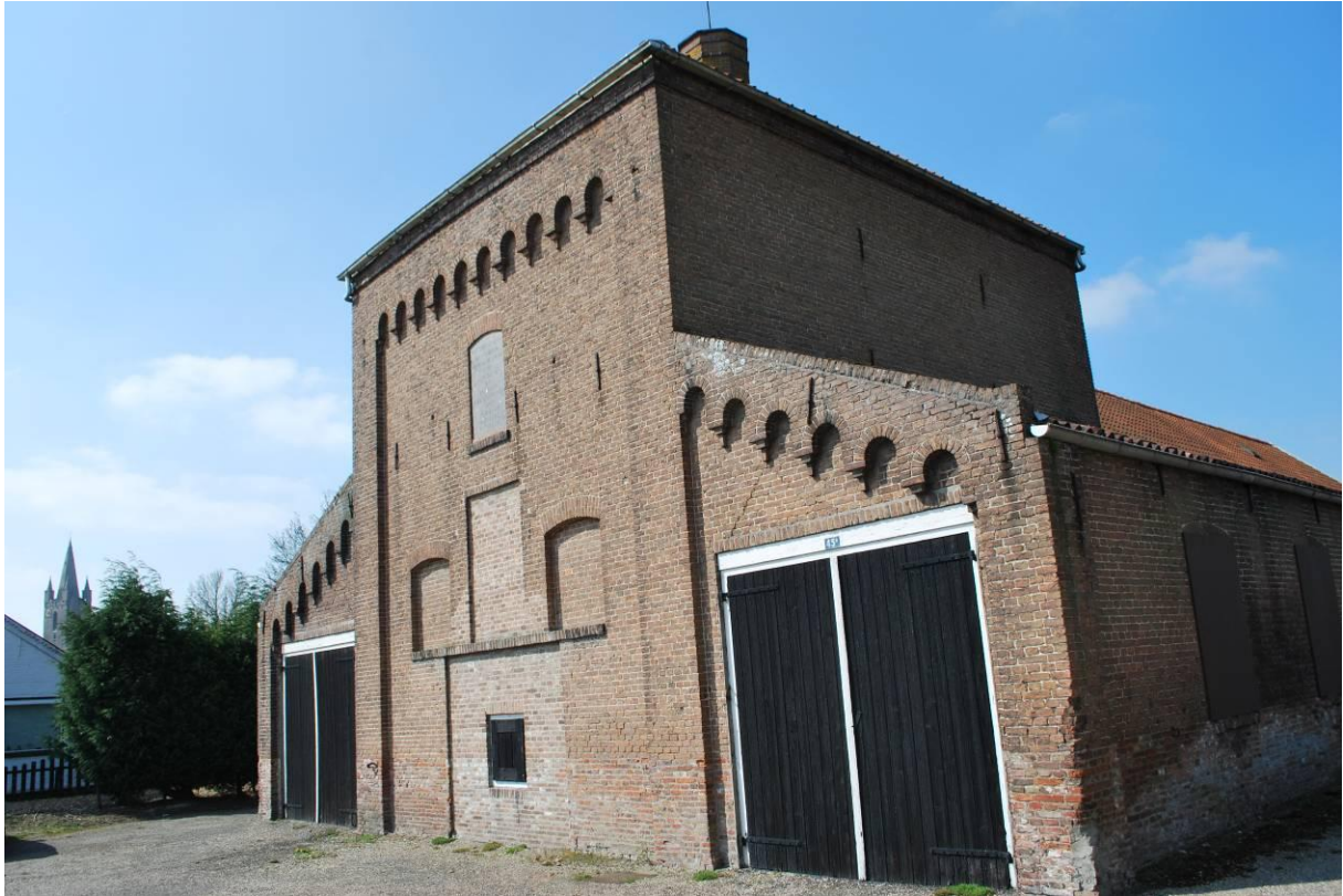
Figuur 1: voorgevel Meekrapstooftoren aan de Ooststraat in Kapelle
