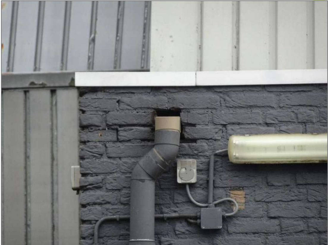
Figuur 2: Hemelwaterafvoer via regenpijp, ruimte boven de regenpijp en de daktrim wijkt licht van de gevel, gezien vanuit het zuiden. Deze plekken zijn geschikt voor vleermuizen. Foto: W. Mans-Naaijer | Ecoresult B.V.
