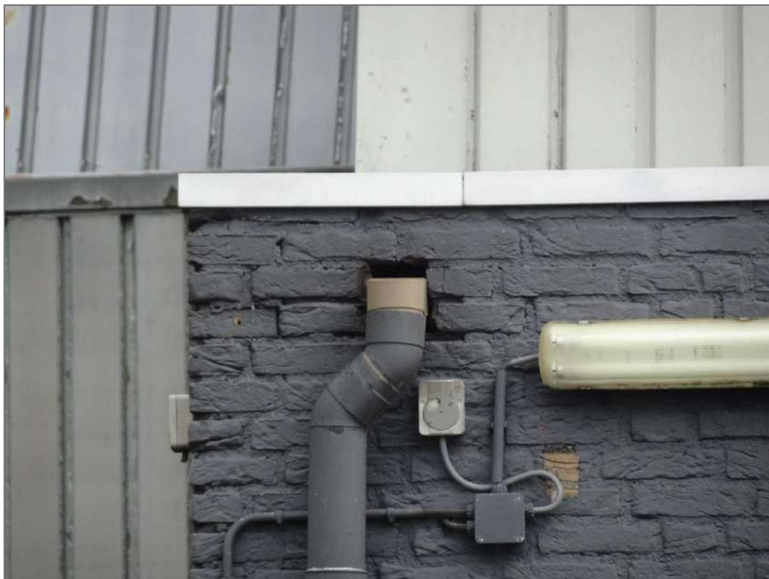
Figuur 3: Hemelwaterafvoer via regenpijp, ruimte boven de regenpijp en de daktrim wijkt licht van de gevel, gezien vanuit het zuiden. Deze plekken zijn geschikt voor vleermuizen. Foto: W. Mans-Naaijer | Ecoresult B.V.
