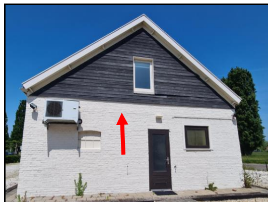
Afbeelding 4: Ruimte achter houten gevelbekleding
