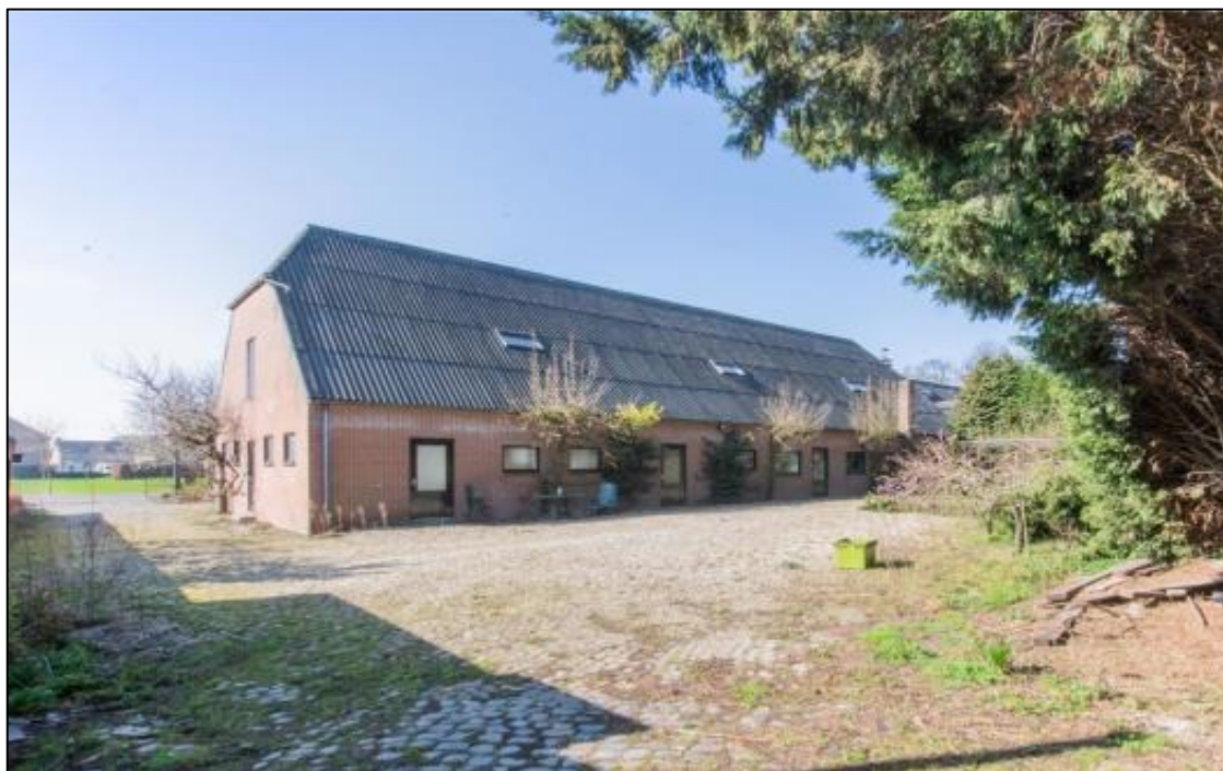
Figuur 2: Huidige situatie van de achterkant (noordzijde) van het gebouw. Te zien is de weinige vegetatie rondom het gebouw.
