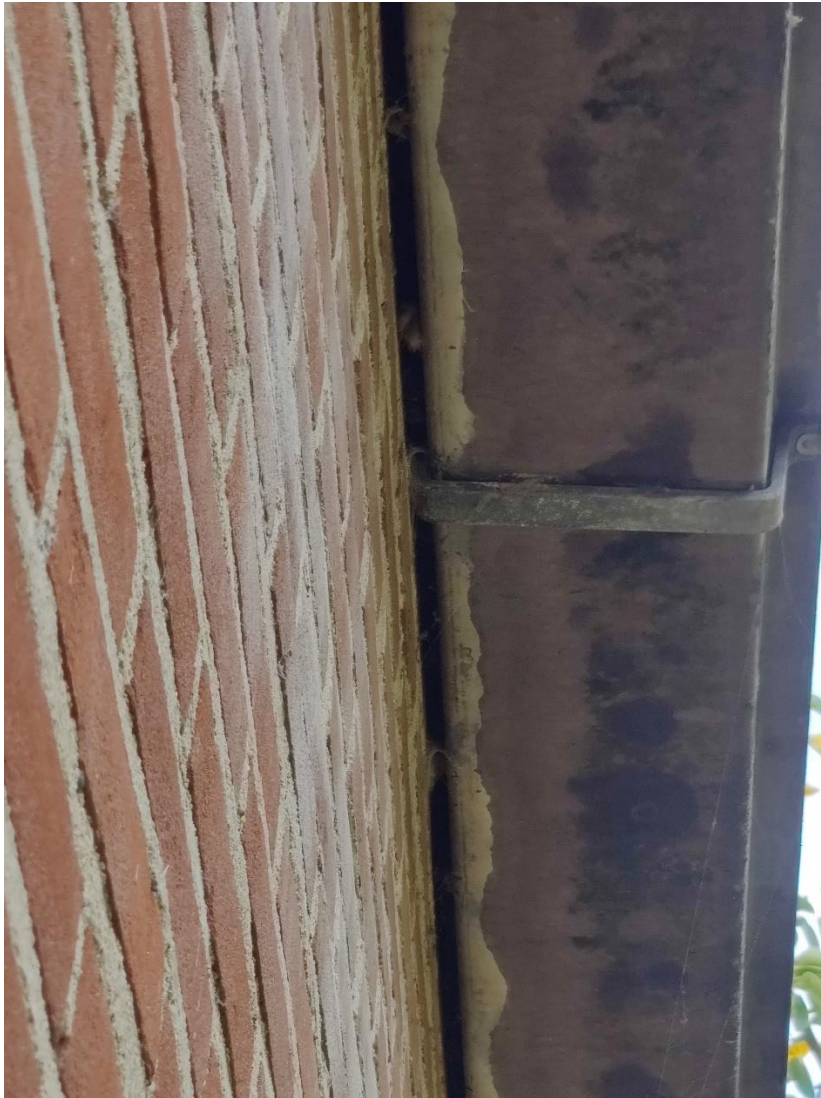
Foto 1: Ruimte achter de dakgoot aan de noordelijke zijde van de schuur.
