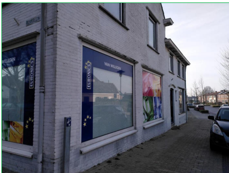
Foto 2 Voorzijde / westzijde pand aan de Van der Biltlaan
