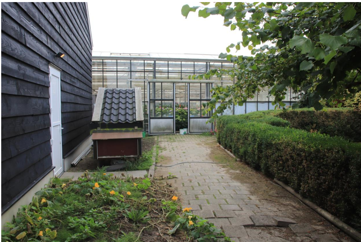
Foto 1: Beeld op de te slopen kas
