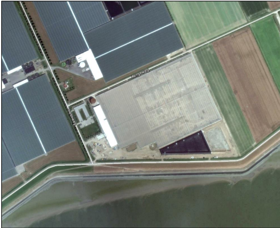
figuur 1 glastuinbouwbedrijf Kwekerij Willem-Annapolder B.V. in aanbouw (foto 2016)
