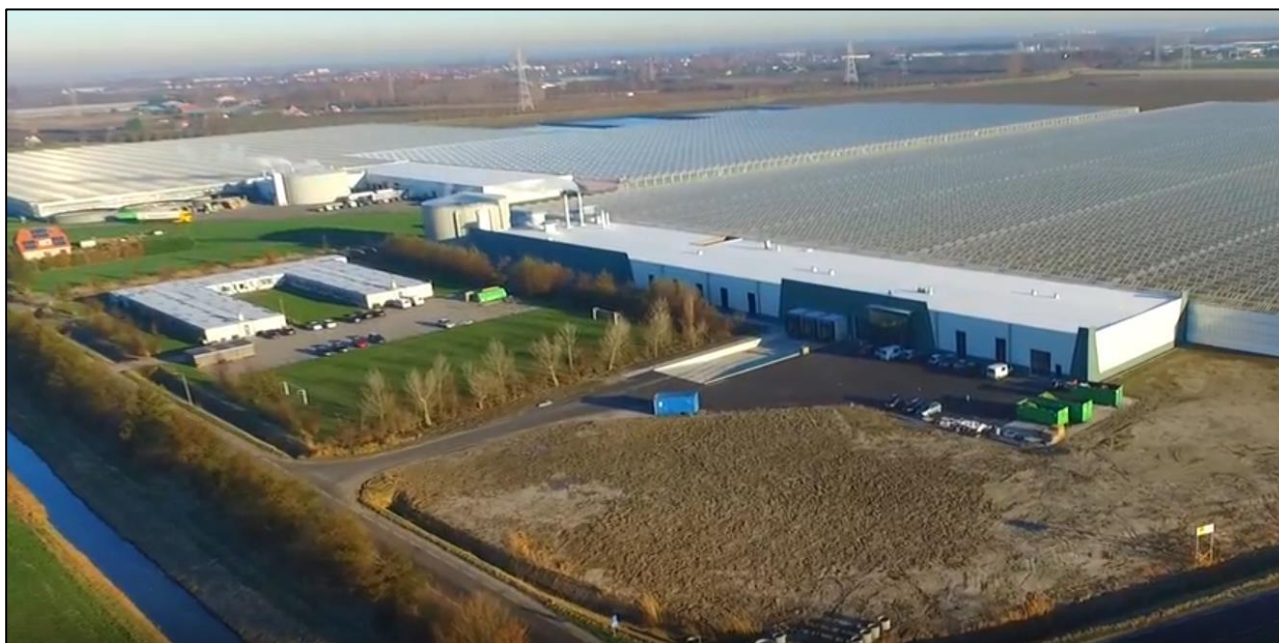
figuur 4 Woonunits Kreekweg 3 & bedrijfsbebouwing
