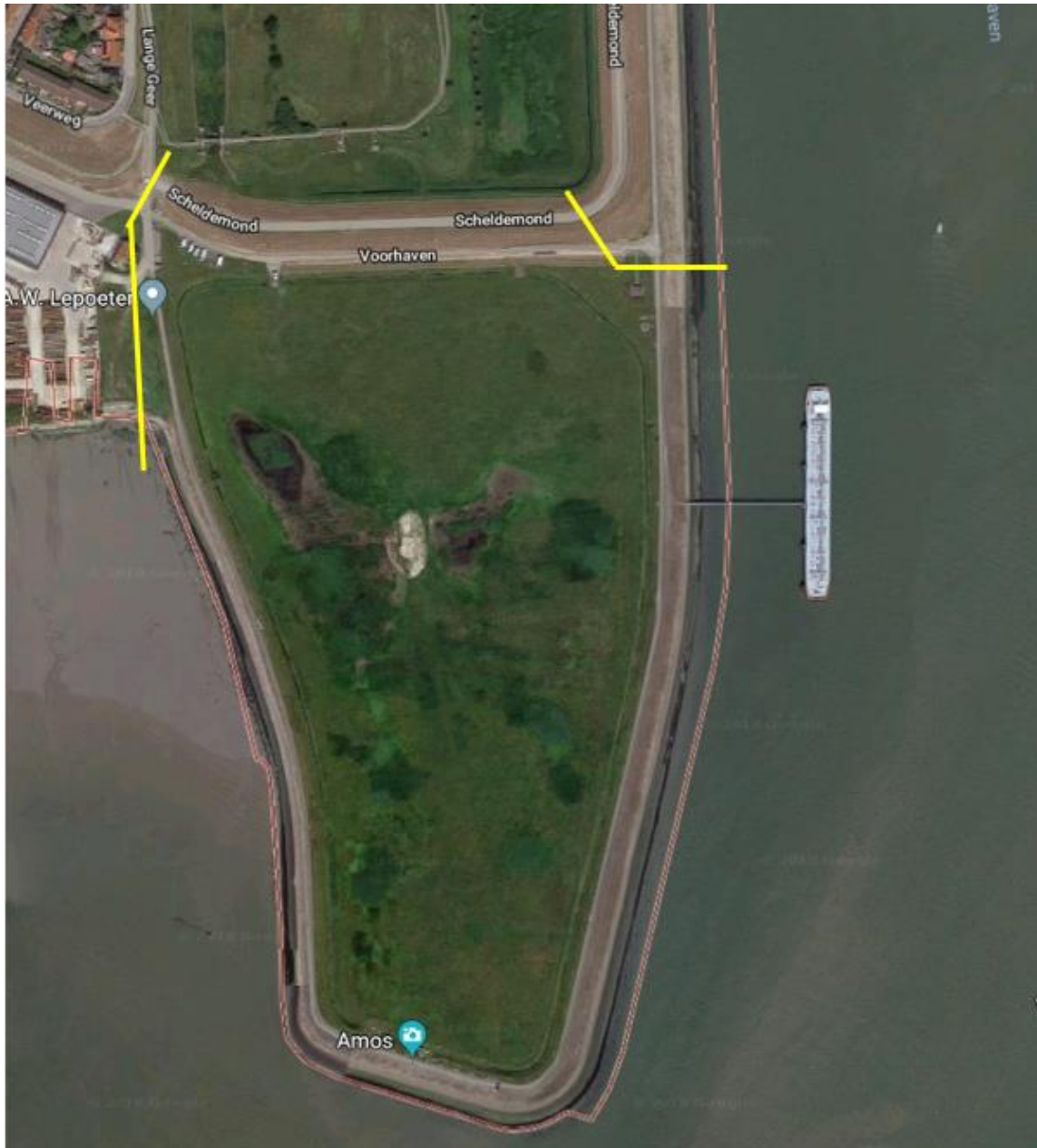
Afbeelding 2.4 Luchtfoto Slibdepot, dijksectie tussen gele markeringen ( www.google.com/maps )
