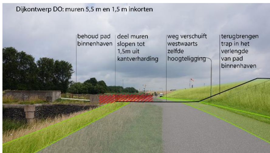
Afbeelding 2.12 Gekozen inpassing sluishoofd waarbij muren worden
