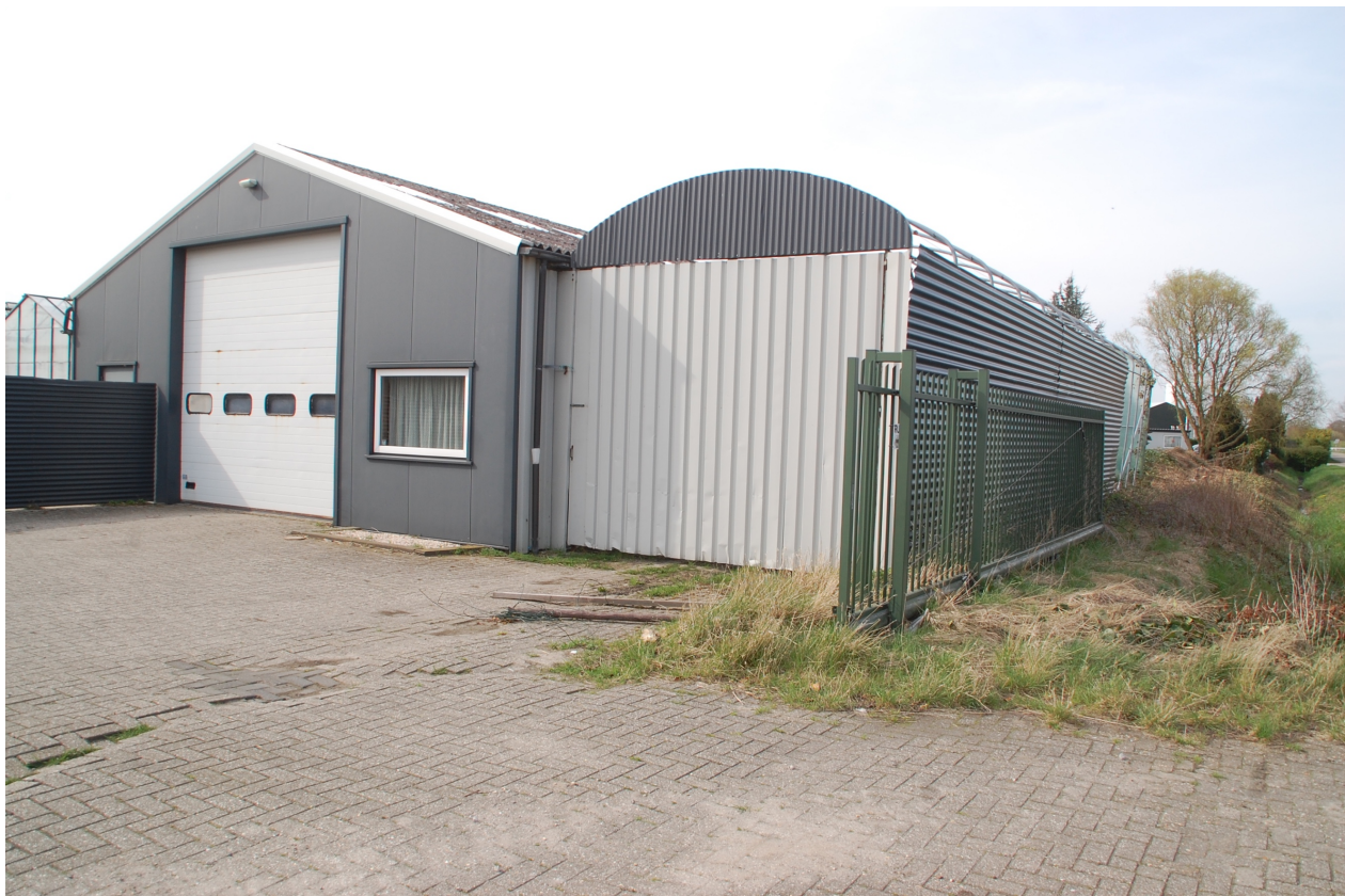
Foto 1. Te slopen schuur en afdak Noordhoeksewegeling 3.
