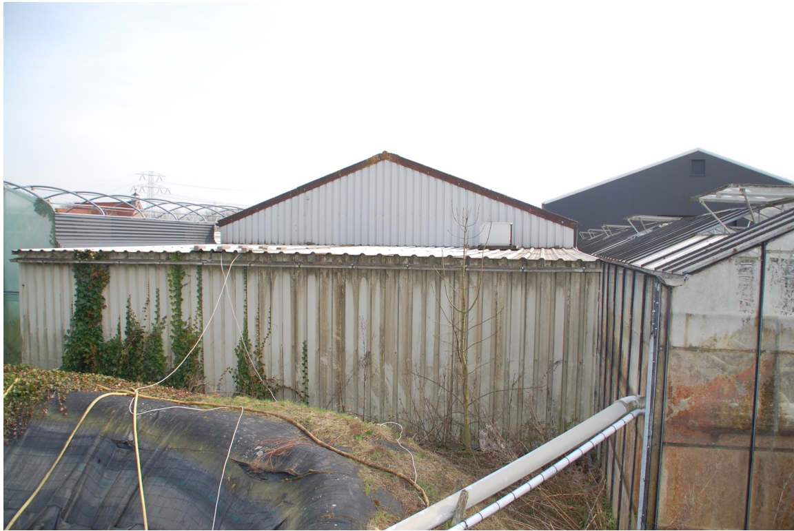
Foto 4. Te slopen schuur en kassen achterzijde.
