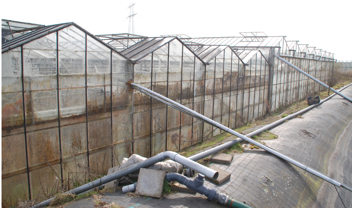
Foto 5. Te slopen kassen achterzijde.
