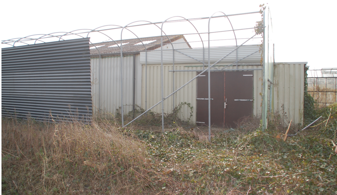
Foto 3. Te slopen schuur en afdak aan achterzijde.
