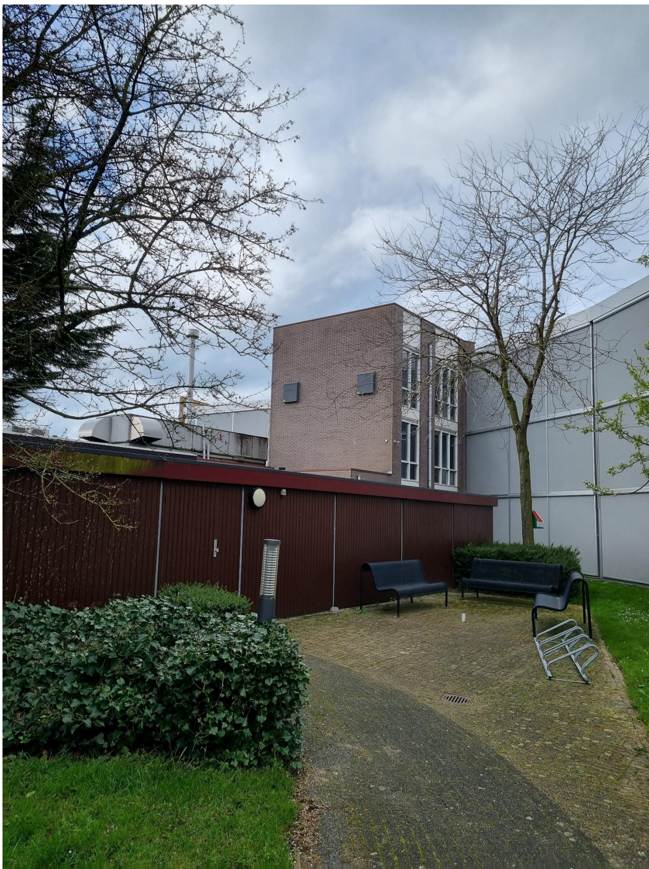
Figuur 2 Twee kraamkasten op kopgevel
