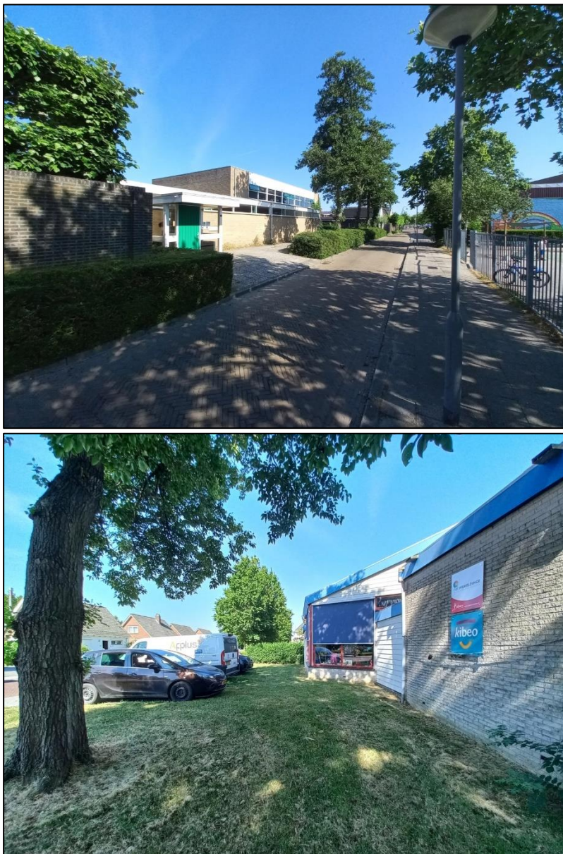
Figuur 1.2.: een impressie van de te slopen bebouwing in het plangebied.
