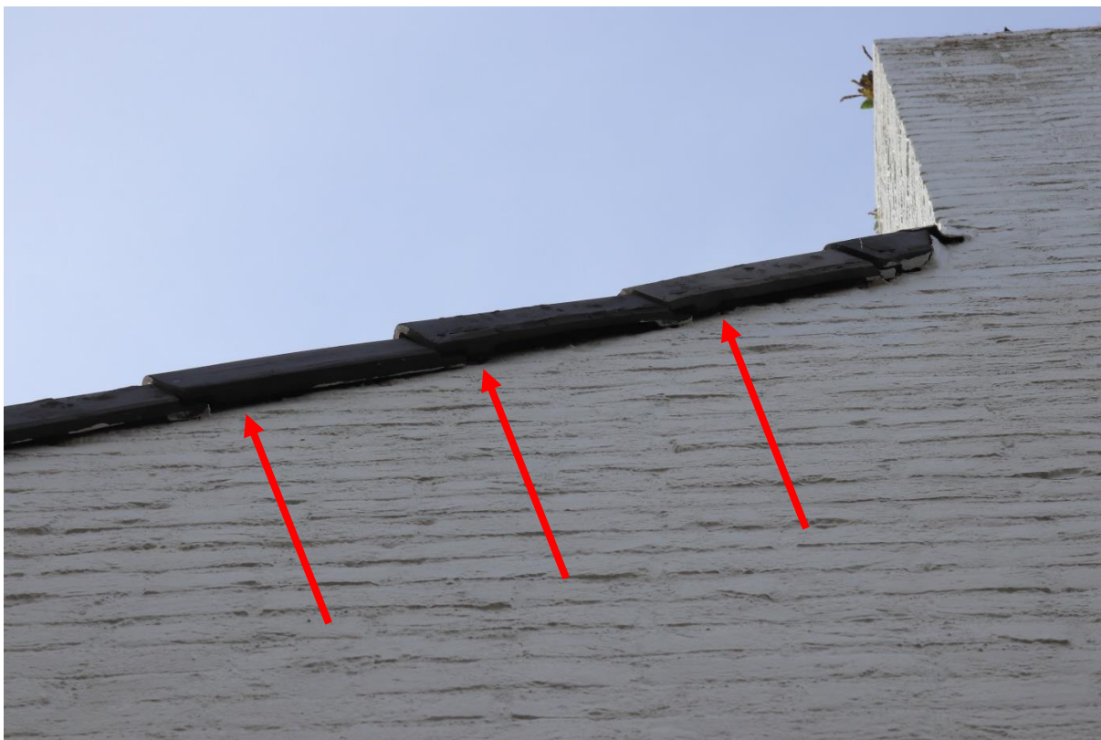
Foto 4: Aan de noordzijde van het pand Dorpsplein 6 is voldoende ruimte voor gebouwbewonende vleermuizen aanwezig onder de dakkantpannen
