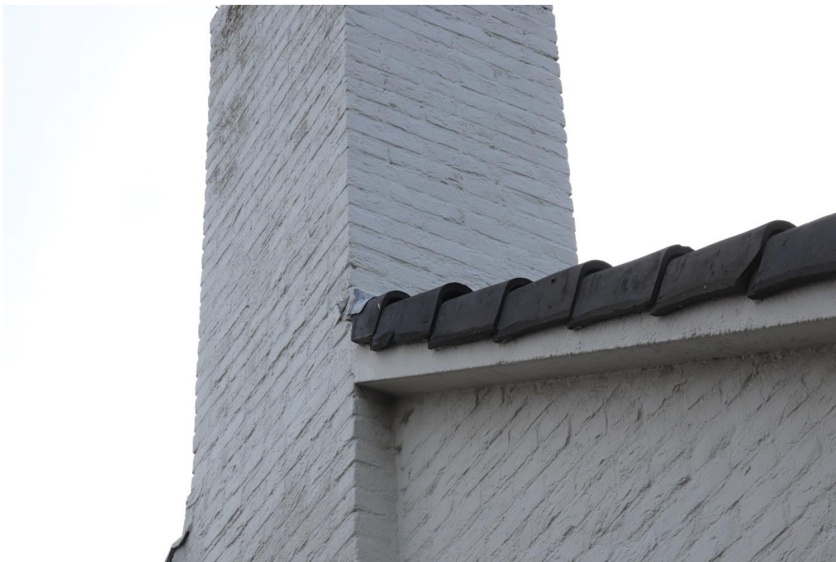
Foto 3: De ruimte onder de dakkantpannen, aan de noordzijde van het pand Dorpsplein 6, is te krap voor gierwaluw om te dienen als nestlocatie
