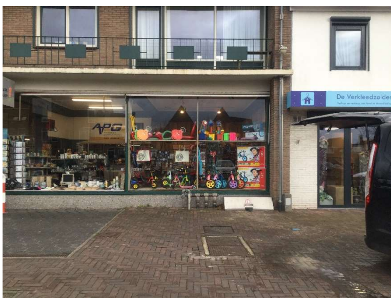
Voorzijde, vul- en ontluftpunt, OBAS
