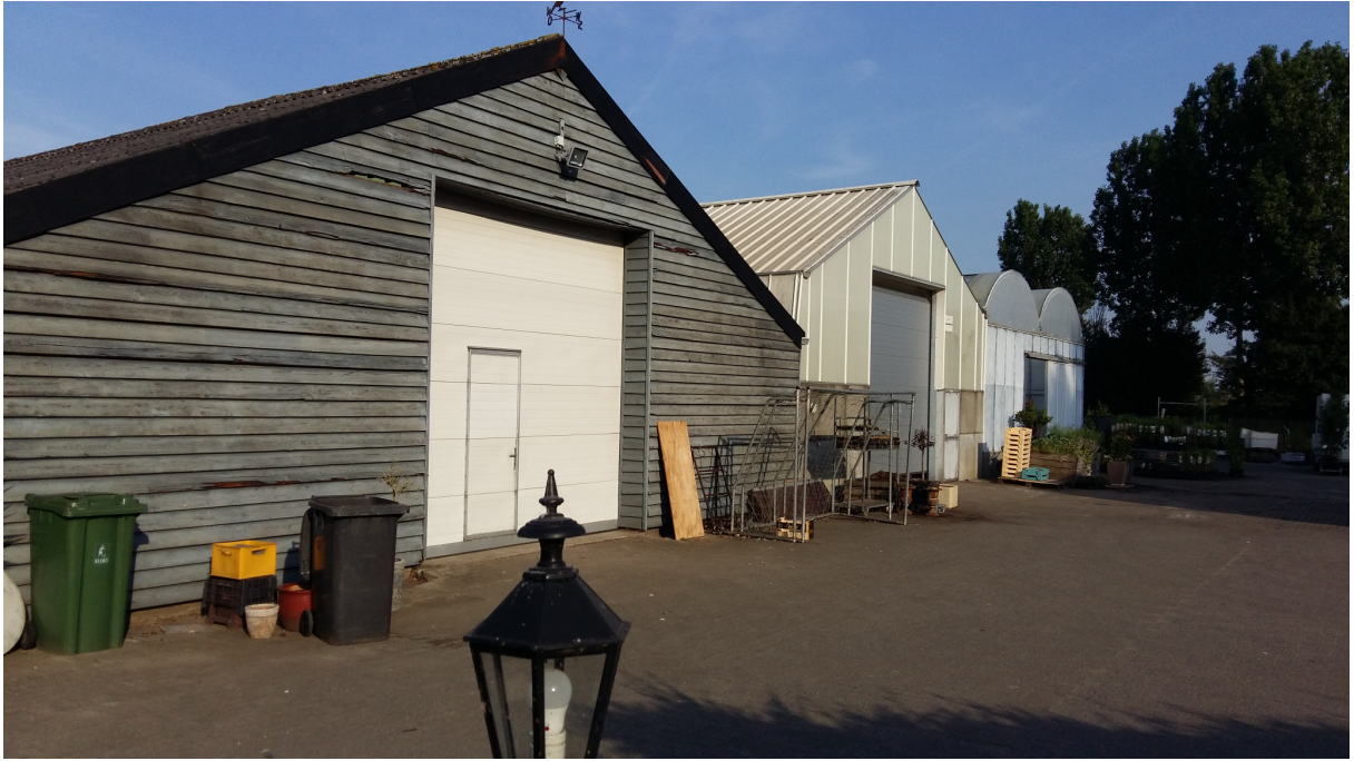
figuur 1.3e impressie aanwezige bebouwing; loodsen en broeikas
