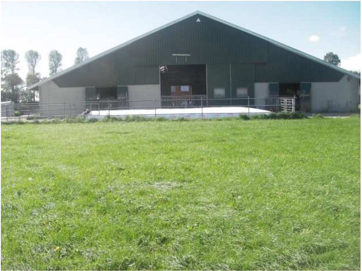
Figuur 18: Het plangebied gezien vanuit het oosten
