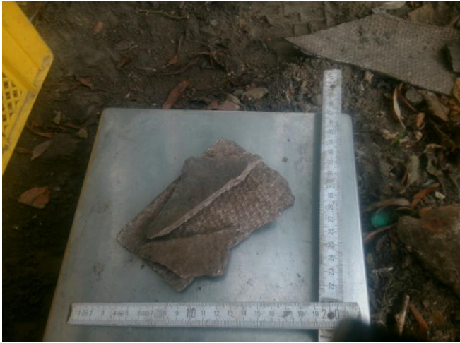
AVM uit inspectiesleuf SL04
